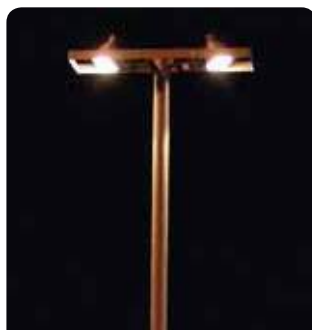
Exemple d'un faisceau lumineux orienté correctement vers le sol.
