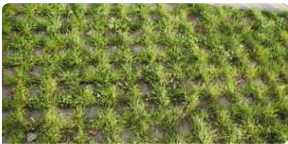
Cheminement en dallage non-jointoyé au parc Ouagadougou. Grenoble, 160 000 hab.
