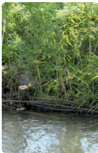
Fascines de saules permettant de stopper l'érosion des pieds de berges. Parc des Ruies, Eybens 10 000 hab.
