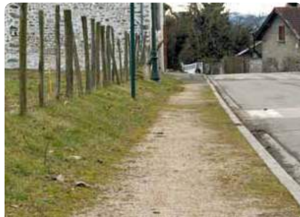
Verdissement d'un trottoir. Le passage des usagers maintient la végétation rase. Champagnier, 1 300 hab.
