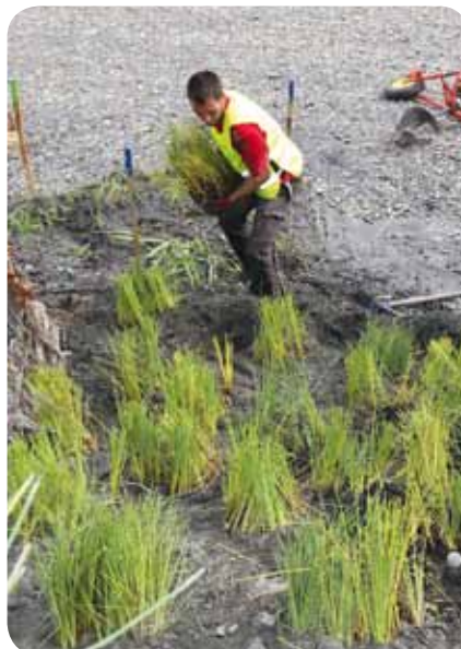
Travaux de plantation de petite massette, plante protégée, demandant une bonne connaissance écologique de l'espèce. Projet d'aménagement hydraulique « Isère amont » du SYMBHL.
