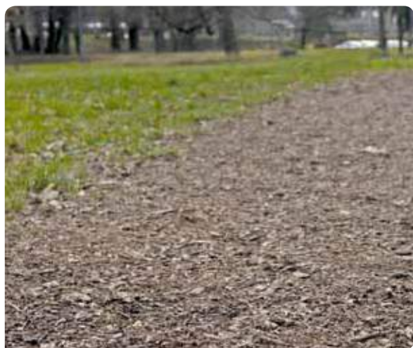
Les cheminements réalisés en broyats permettent de valoriser les déchets en produisant un aménagement facile d'entretien. Grenoble 160 000 hab.
