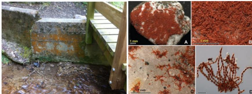
**Photo de gauche :** Taches de Trentepohlia sur des substrats bétonnés à Saint-Martin d'Hères (38)
